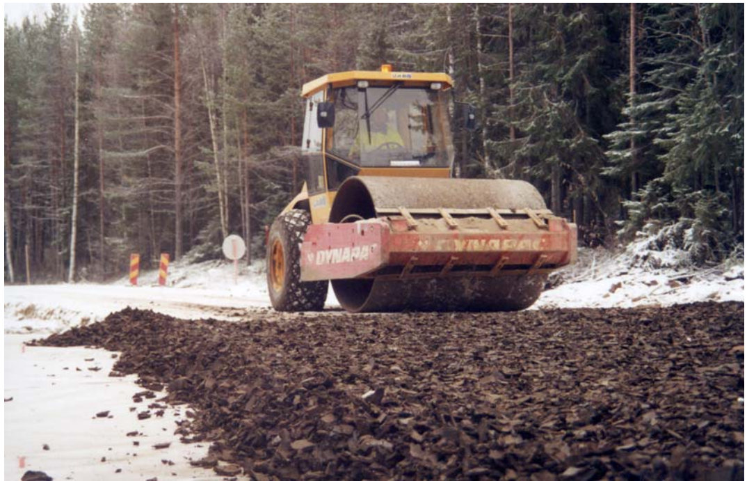
Figur B7. Packing av tjälisole- ringslager i väg 686 hösten 2002.
